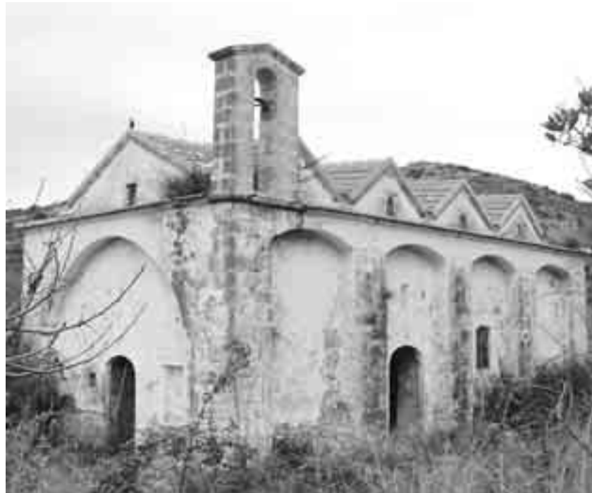
Η εκκλησία της Αγίας Παρασκευής στον Παλαιόσοφο, με εμφανή τα σημάδια της καταστροφής.
